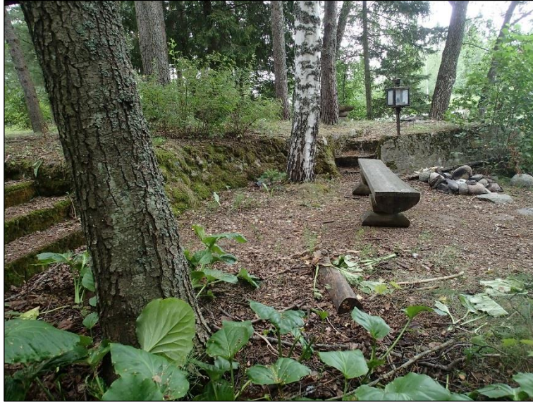
Betonirakenteita rantasaunan ja rannan välissä.
